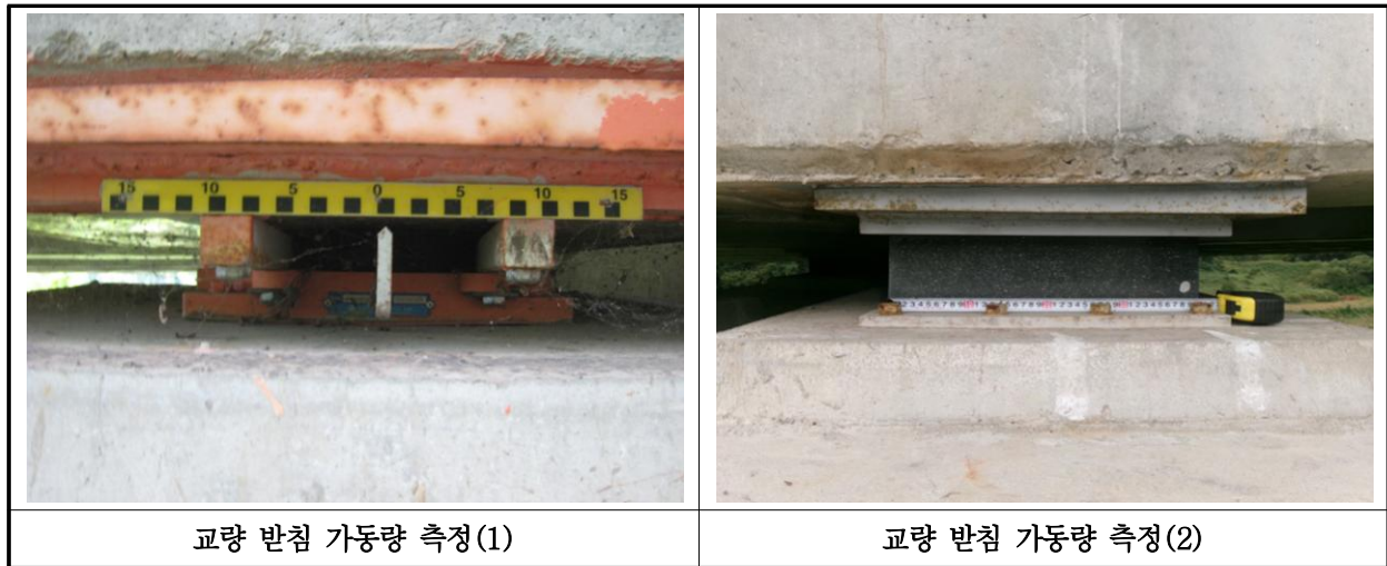
【사진 11.3.15】 교량받침 이동량 측정
