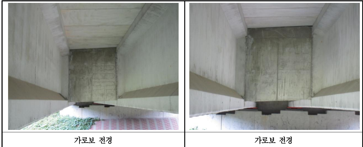
【사진 11.3.31】 가로보 전경
