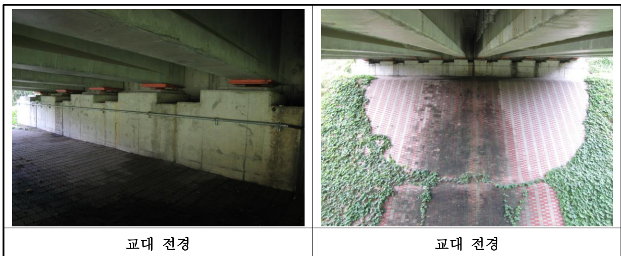
【사진 11.3.8】 교대 전경
