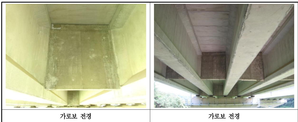
【사진 11.3.6】 가로보 전경
