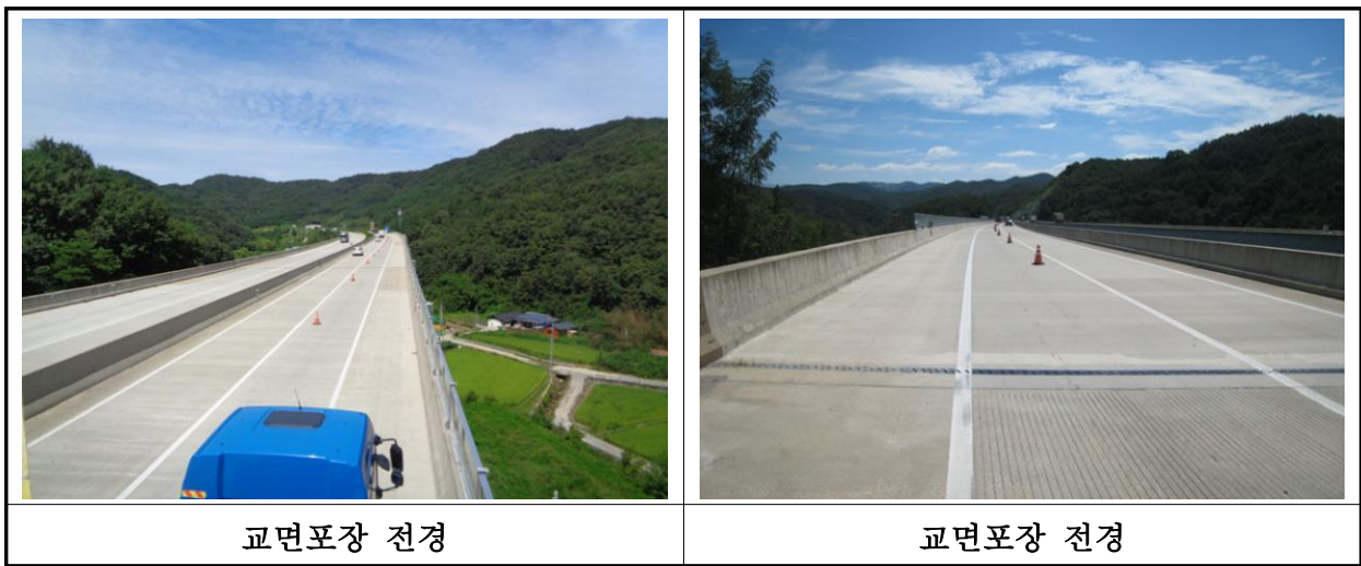
【사진 11.3.19】 교면포장 전경
