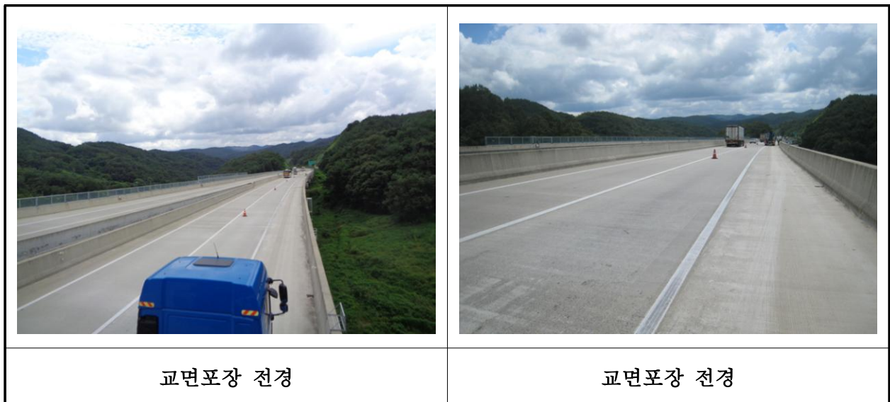
【사진 11.3.44】 교면포장 전경
