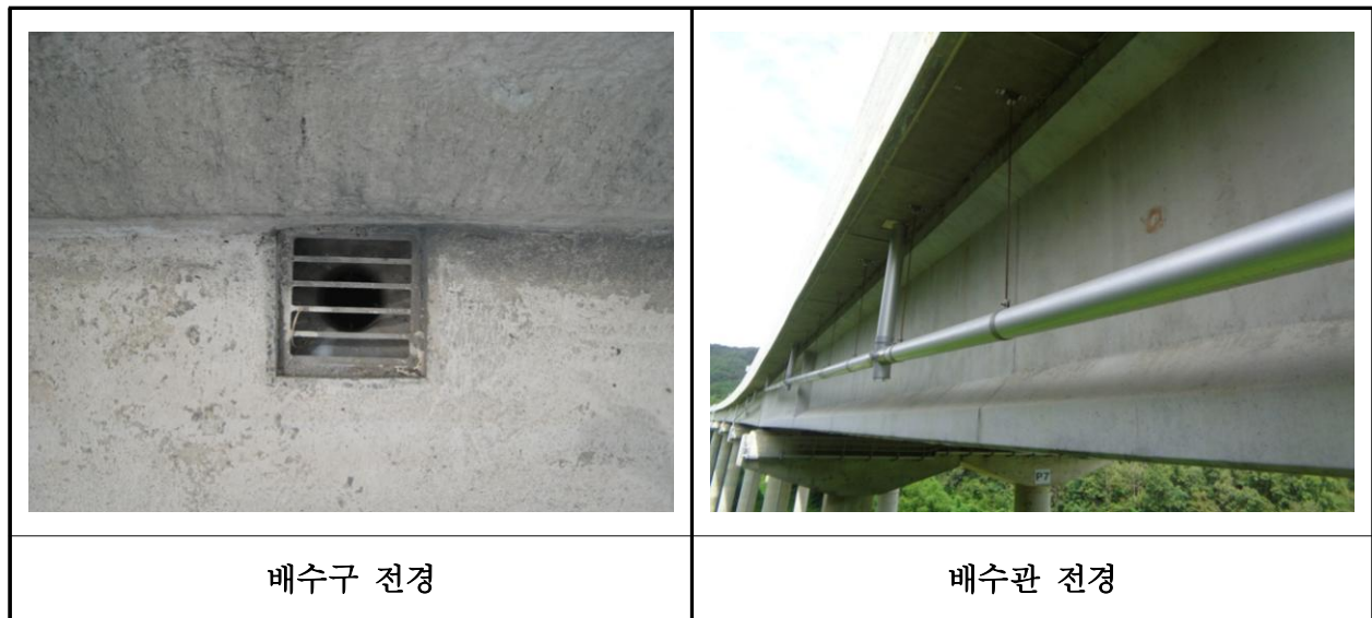
【사진 11.3.46】 배수시설 전경
