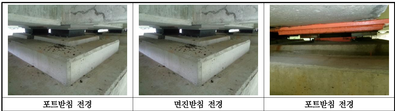
【사진 11.3.12】 교량반침 전경
