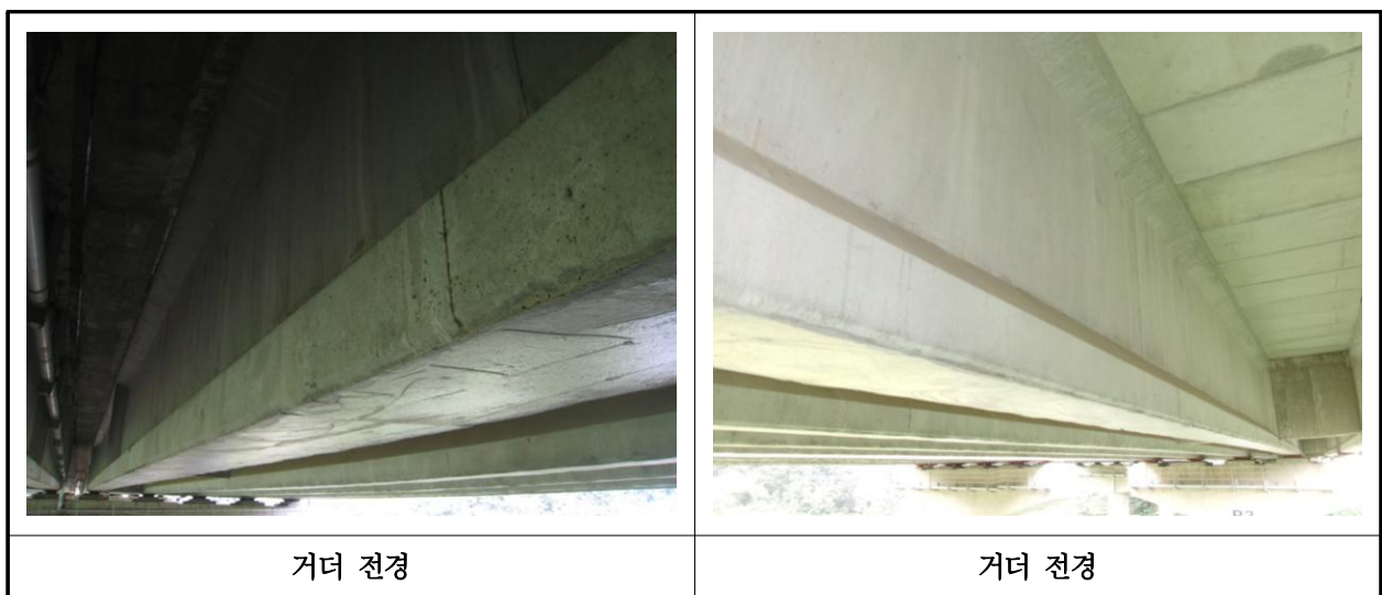
【사진 11.3.4】 거더 전경
