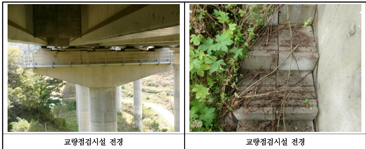
【사진 11.3.50】 교량 점검시설 전경
