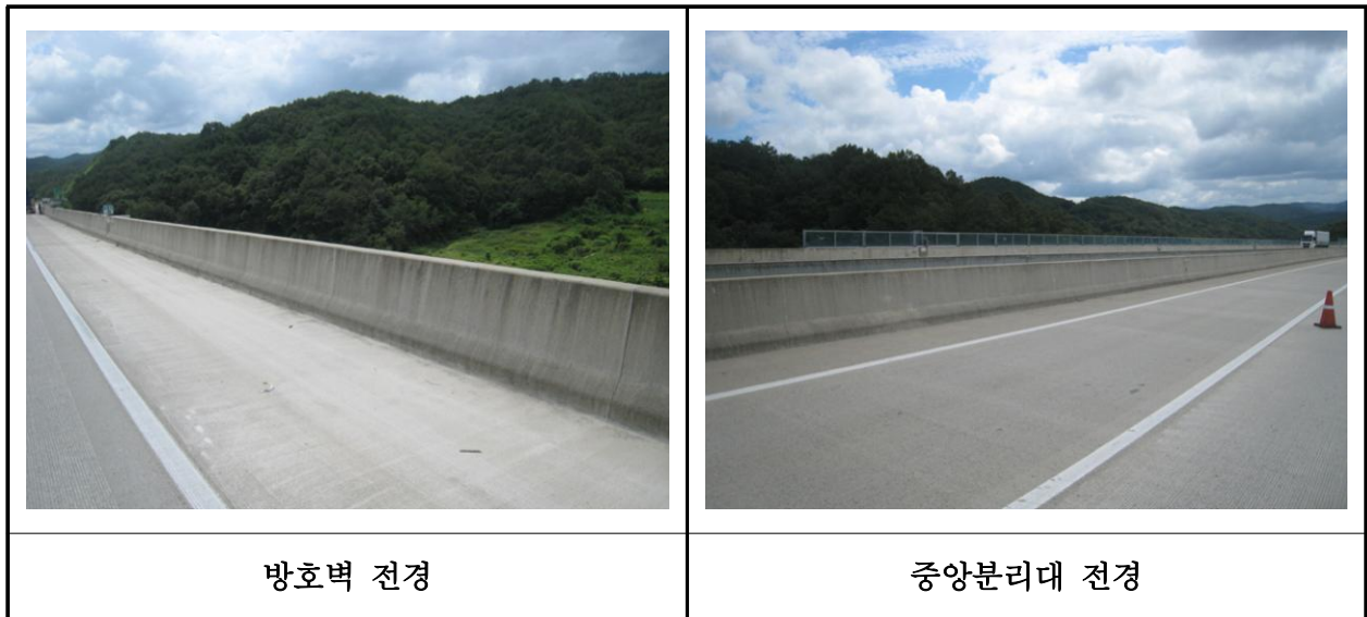
【사진 11.3.48】 방호벽 및 중앙분리대 전경
