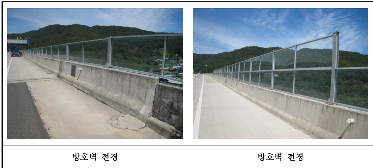
【사진 11.3.23】 방호벽 및 중앙분리대 전경
