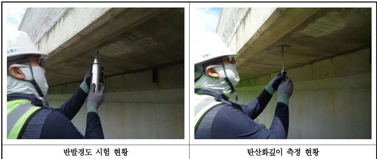
【사진 11.4.1】 콘크리트 내구성조사 현황
