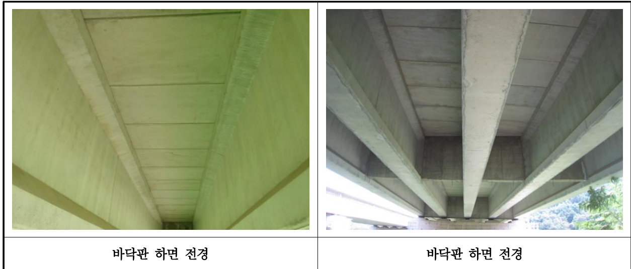
【사진 11.3.27】 바닥판하면 전경
