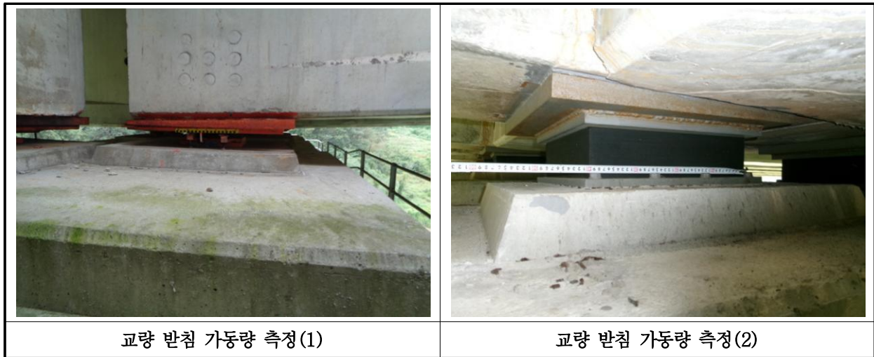
【사진 11.3.40】 교량받침 이동량 측정
