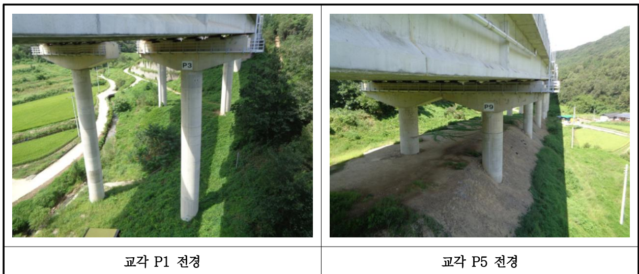
【사진 11.3.10】 교각 전경
