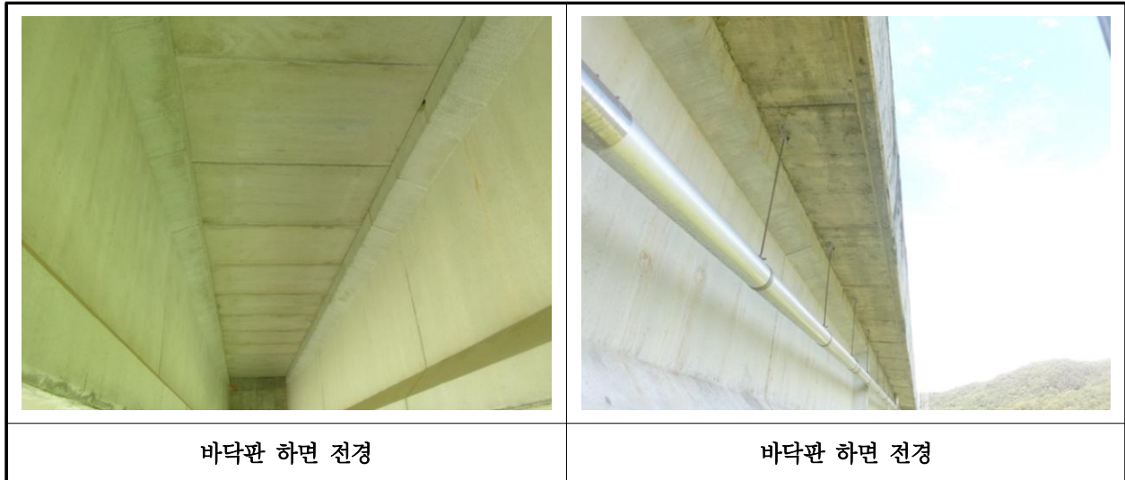
【사진 11.3.2】바닥판하면 전경
