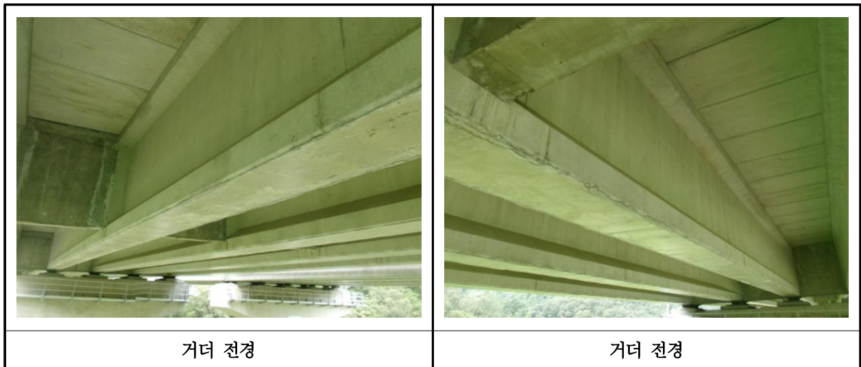
【사진 11.3.29】 거더 전경
