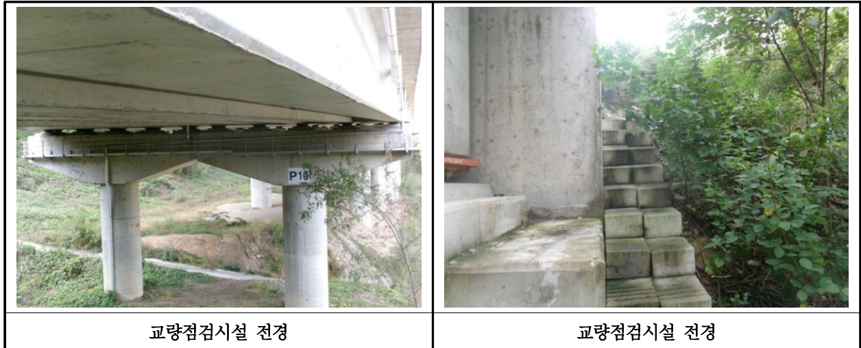
【사진 11.3.25】 교량 점검시설 전경
