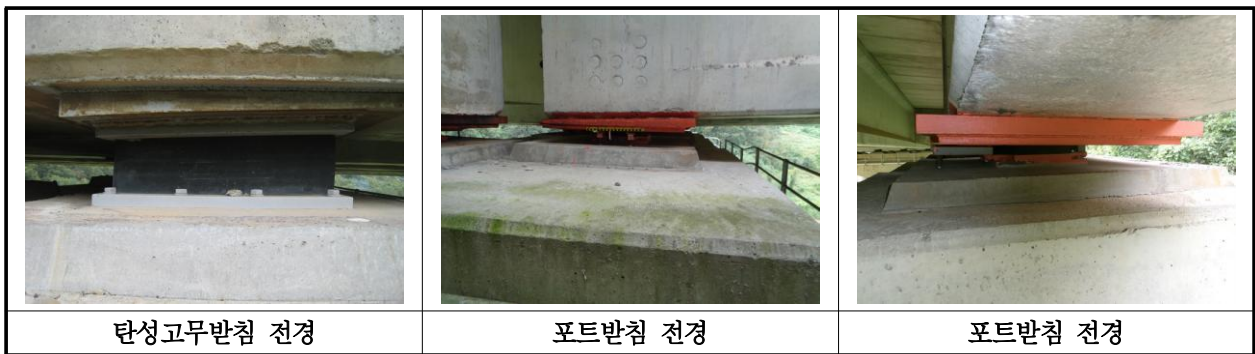
【사진 11.3.37】 교량반침 전경
